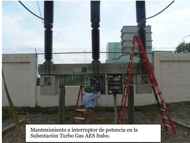
Mantenimiento a interruptor de potencia en la Subestación Turbo Gas AES Itabo.
