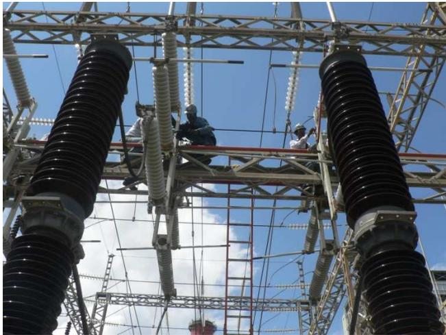
Mantenimiento a aisladores y calibración de cuchillas seccionadoras, Subestación Turbo Gas, AES Itabo.
