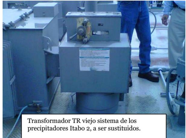
Transformador TR viejo sistema de los precipitadores Itabo 2, a ser sustituidos.
