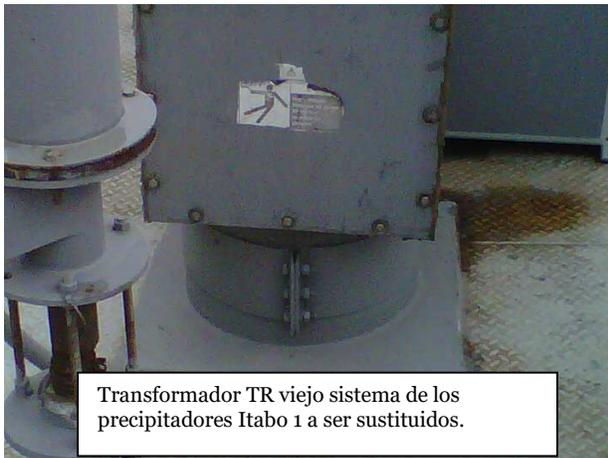
Transformador TR viejo sistema de los precipitadores Itabo 1 a ser sustituidos.
