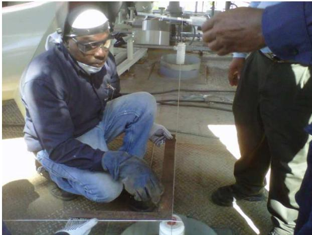
Trabajos del trazado para instalar las bases de los nuevos Transformadores de alta frecuencia.
