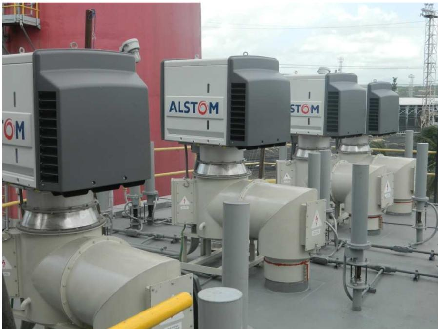
Disposición final de los Transformadores de alta frecuencia de los Precipitadores Electrostáticos C. T. Itabo.
